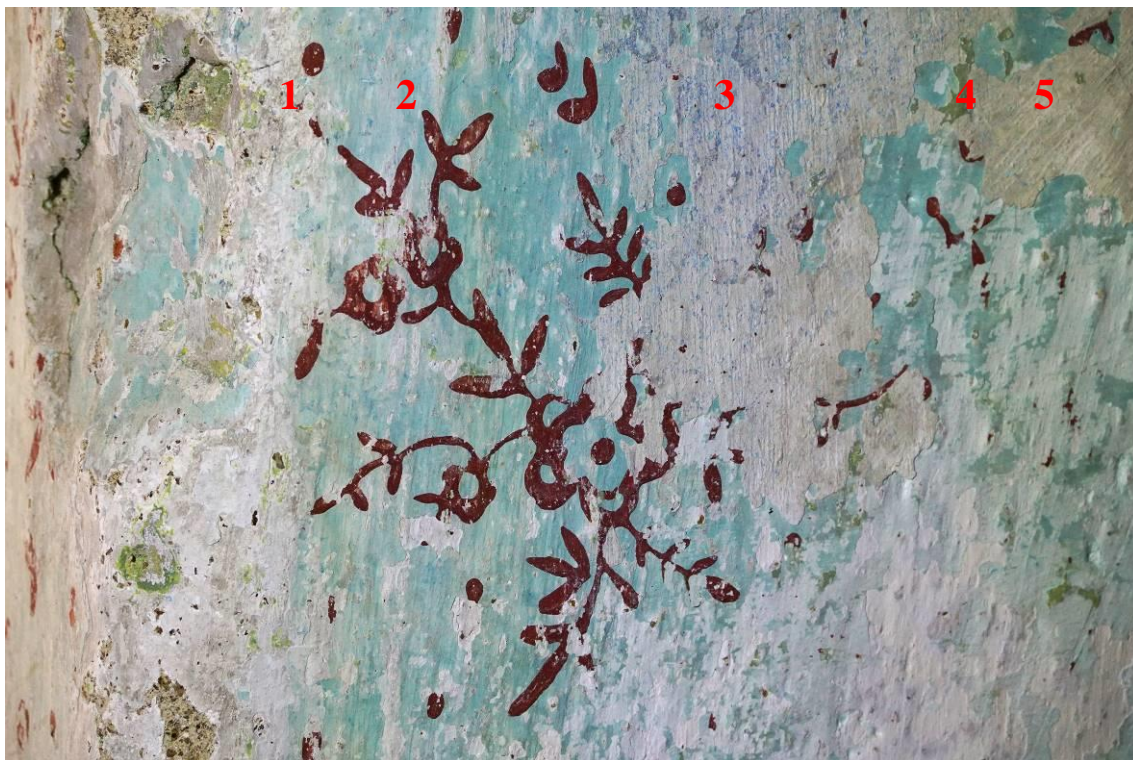
Obr. 9. Sonda č. 1NP/CH/SO1. 1: Vápenný nátěr bílý. 2: Světle modrá azurová s tmavě červeným válečkem. 3: Modrá ultramarínová. 4: Zelená. 5: Vápenný nátěr, silně znečištěn.
