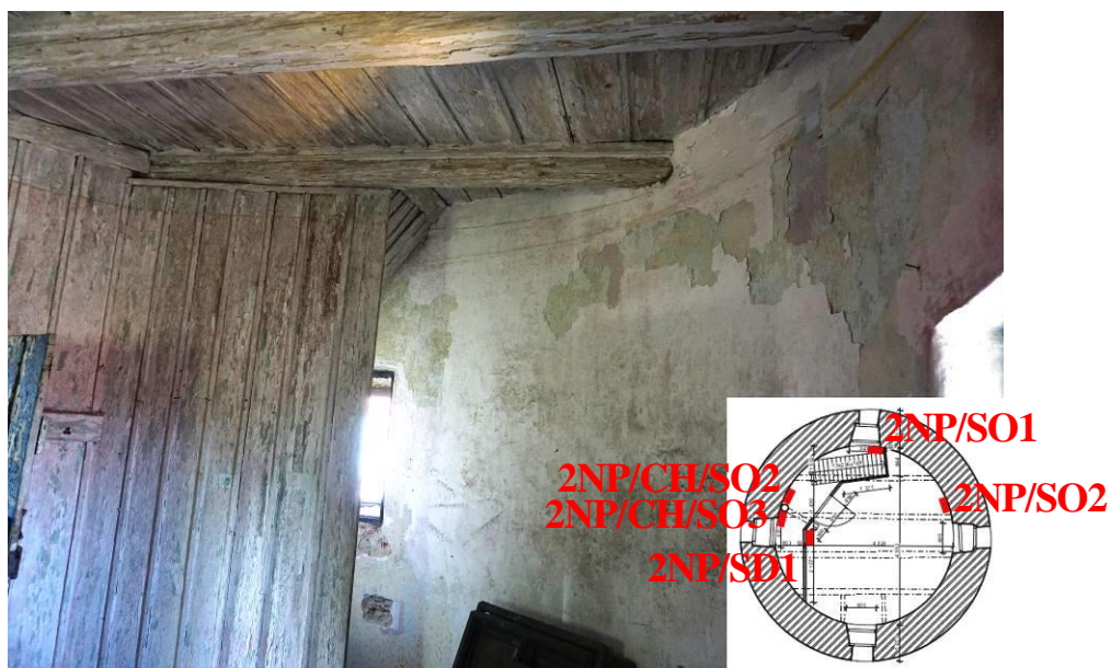
Obr. 10. Pohled do 2 NP a lokace provedených sond v místnosti a příslušné části chodby.
