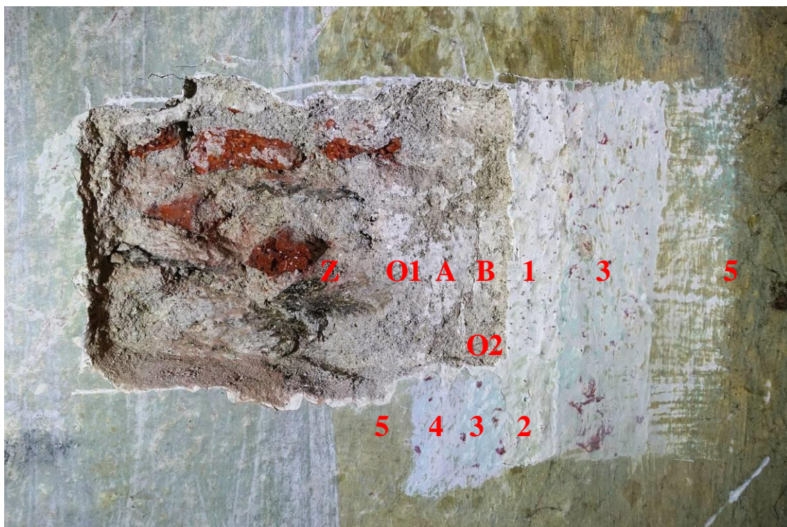
Obr. 7. Sonda č. 2NP/CH/SO2. O1: Vápenná omítka z 1836. A, B: Lomené, většinou dvouvrstvé, bílé vápenné nátěry. O2: Vápenná omítka z 1929–1932. 1: Vápenný nátěr bílý. 2: Světle zelená veroneská. 3: Světle modrá azurová s tmavě červeným válečkem. 4: Světle modrá ultramarínová. 5: Zelená hlinková, silně znečištěna.
