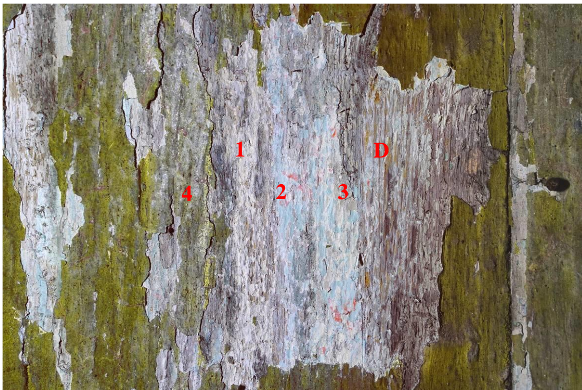
Obr. 6. Sonda č. 1NP/SD1. D: dřevěná příčka z 1929–1932. 1: Vápenný nátěr bílý. 2: Světle modrá azurová s červeným válečkem. 3: Světle okrová s tmavě okrovým válečkem. 4: Žluto-zelená, silně znečištěna a mikrobiologicky poškozena. Vrstvy nebylo možné vzhledem k nesoudržnosti stratigraficky rozkrýt.
