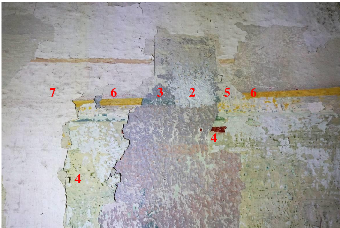
Obr. 12. Sonda č. 2NP/SO2. 1: Vápenný nátěr bílý. 2: Světle modrá ultramarínová. 3: Světle růžová ultramarínová se zeleným válečkem a zelenou linkou pod stropem. 4: Světle zelená veroneská s tmavě zeleným válečkem a třemi linkami pod stropem – horní žlutou, prostřední tmavě zelenou a dolní tmavě červenou. 5: Světle zelená. 6: Lomená bílá se žlutým válečkem a žlutou linkou pod stropem. 6: Vápenný nátěr bílý s okrovou linkou pod stropem. Nátěr je silně znečištěn a mikrobiologicky napaden. Vrstvy nebylo možné vzhledem k nesoudržnosti stratigraficky rozkrýt.
