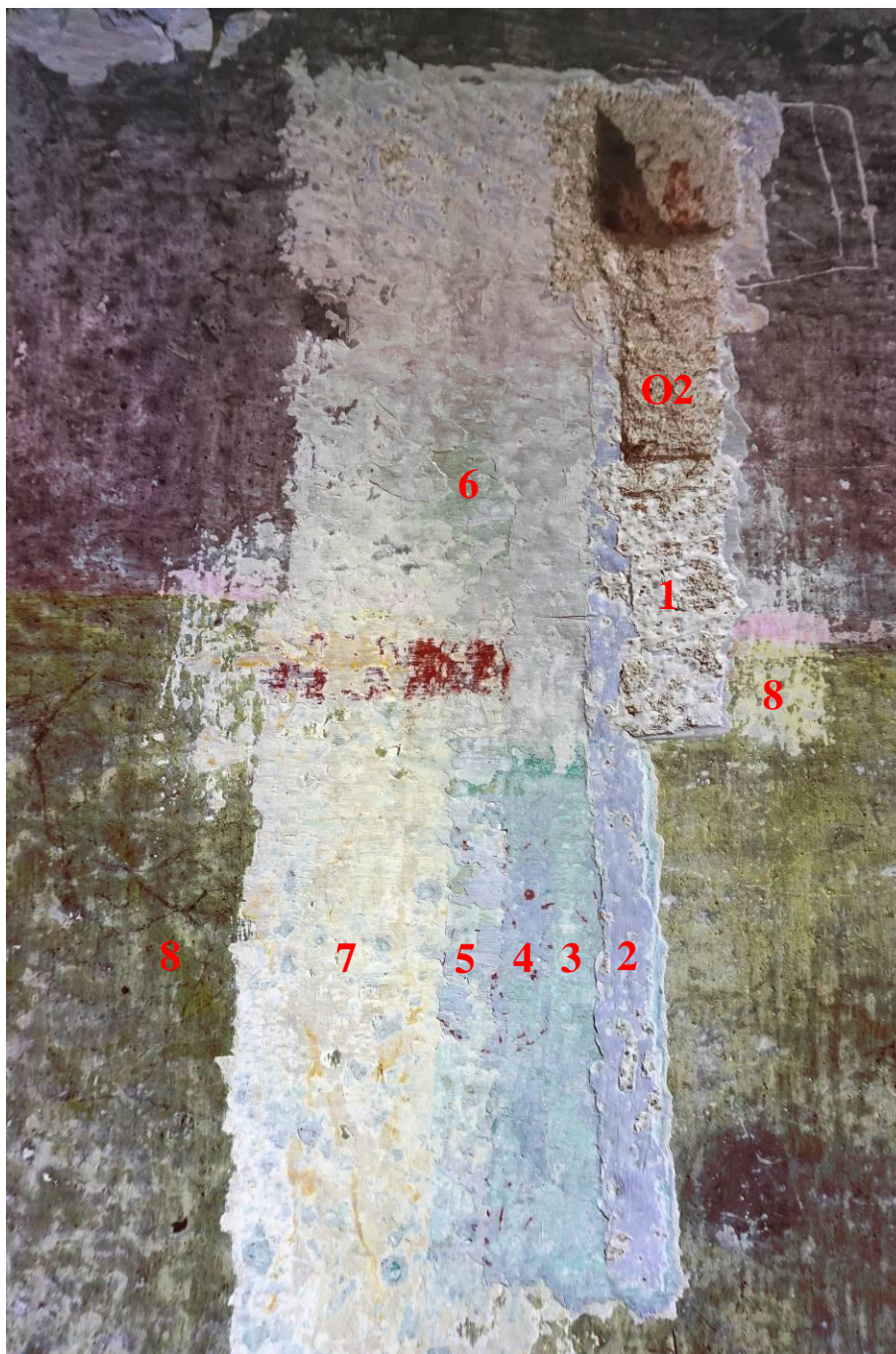
Obr. 3. Sonda č. 1NP/SO2. O2: Vápenná omítka z 1929–1932. 1: Vápenný nátěr bílý. 2: Světle modrá ultramarínová, bez linkování pod stropem. 3: Modrá azurová, zakončená pod stropem se smaragdově zeleným linkováním. Při styku se stropem bílá. 4: Modrá s tmavě červeným válečkem a linkováním pod stropem. 5: Modrá ultramarínová. 6: Světle zelená veroneská. 7: Světle okrová s tmavě okrovým válečkem a linkováním pod stropem. 8: žluto-zelená s růžovým linkováním, silně znečištěna a mikrobiologicky poškozena.
