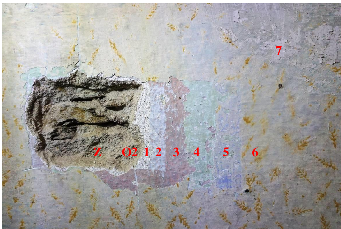
Obr. 11. Sonda č. 2NP/SO1. Z: Smíšené zdivo. O2: Vápenná omítka z 1929–1932. 1: Vápenný nátěr bílý. 2: Světle modrá ultramarínová. 3: Světle růžová ultramarínová se zeleným válečkem. 4: Světle zelená. 5: Modrá ultramarínová. 6: Světle okrová s tmavě okrovým válečkem. 7: Vápenný nátěr bílý.
