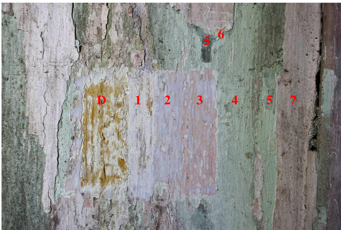
Obr. 13. Sonda č. 2NP/SD1. D: Dřevěná příčka z 1929–1932. 1: Vápenný nátěr bílý. 2: Světle modrá ultramarínová. 3: Světle růžová ultramarínová. 4: Světle zelená. 5: Světle zelená, pravděpodobně s tmavě zeleným válečkem (fragment smaragdově zelené). 6: Lomená bílá se žlutým válečkem. 6: Vápenný nátěr bílý.
