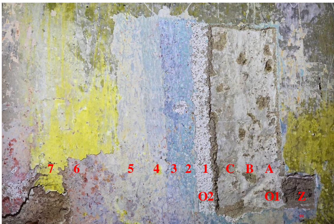
Obr. 2. Sonda č. 1NP/SO1. O1: Vápenná omítka z 1836. A, B, C: Lomené, většinou dvouvrstvé, bílé vápenné nátěry. O2: Vápenná omítka z 1929–1932. 1: Vápenný nátěr bílý. 2: Modrá azurová. 3: Modrá s tmavě červeným válečkem. 4: Světle modrá azurová s červeným válečkem. 5: Světle okrová. 6: Okrovo-růžová s červeným válečkem. 7: Žluto-zelená, silně znečištěna a mikrobiologicky poškozena.
