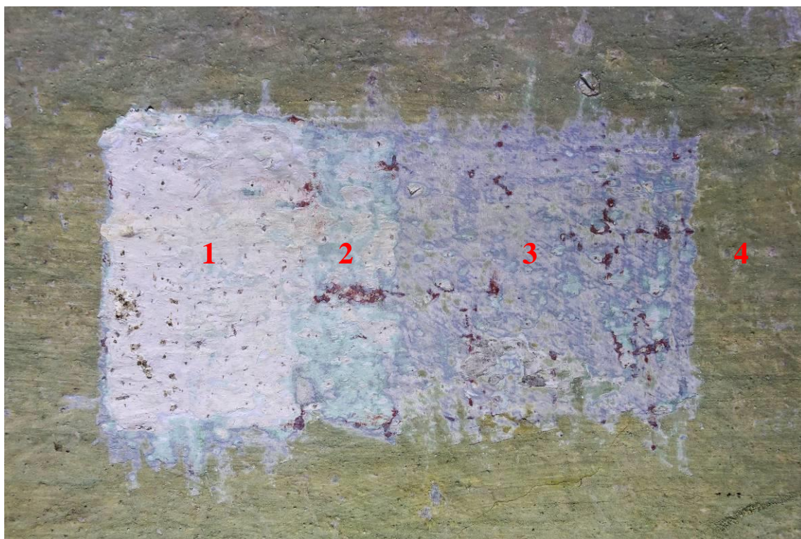
Obr. 8. Sonda č. 2NP/CH/SO3. 1: Vápenný nátěr bílý. 2: Světle modrá azurová s tmavě červeným válečkem. 3: Světle modrá ultramarínová. 4: Zelená hlinková, silně znečištěna.
